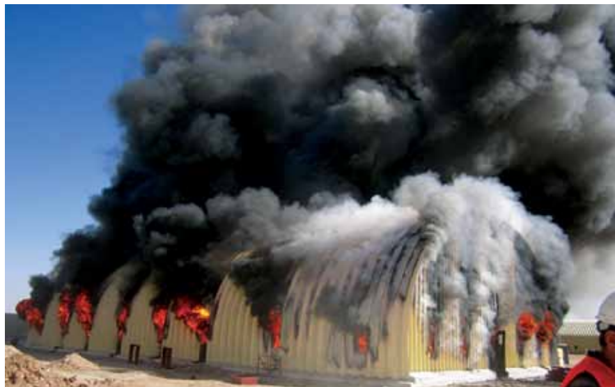
د کوډ اجابت نه کونکي کې اور د ANA یو ټولگی په 30 دقیقو کې له تخریب کړ. ځانگړې پروژه 14-77-SP وگورئ. (د USACE تصویر)
