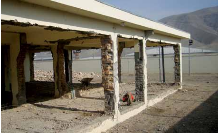
ودانۍ 17، د بغلان محبس درې تړولو جدي زیانمن شوي جوړښتونو څخه یوه د خونديتوب انډیبنو له امله تخریب کړی شوه. د تفتیش راپور IP-62-14 وګورئ. (د INL تصویر)
